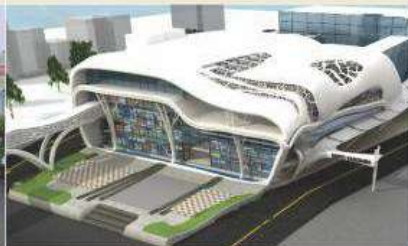
GSRTC Vadodara - 8.5 km
